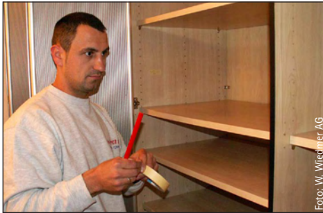
Beschriftet: Ein Mitarbeiter der W. Wiedmer AG kennzeichnet vor der Demontage alle Schrankelemente.
